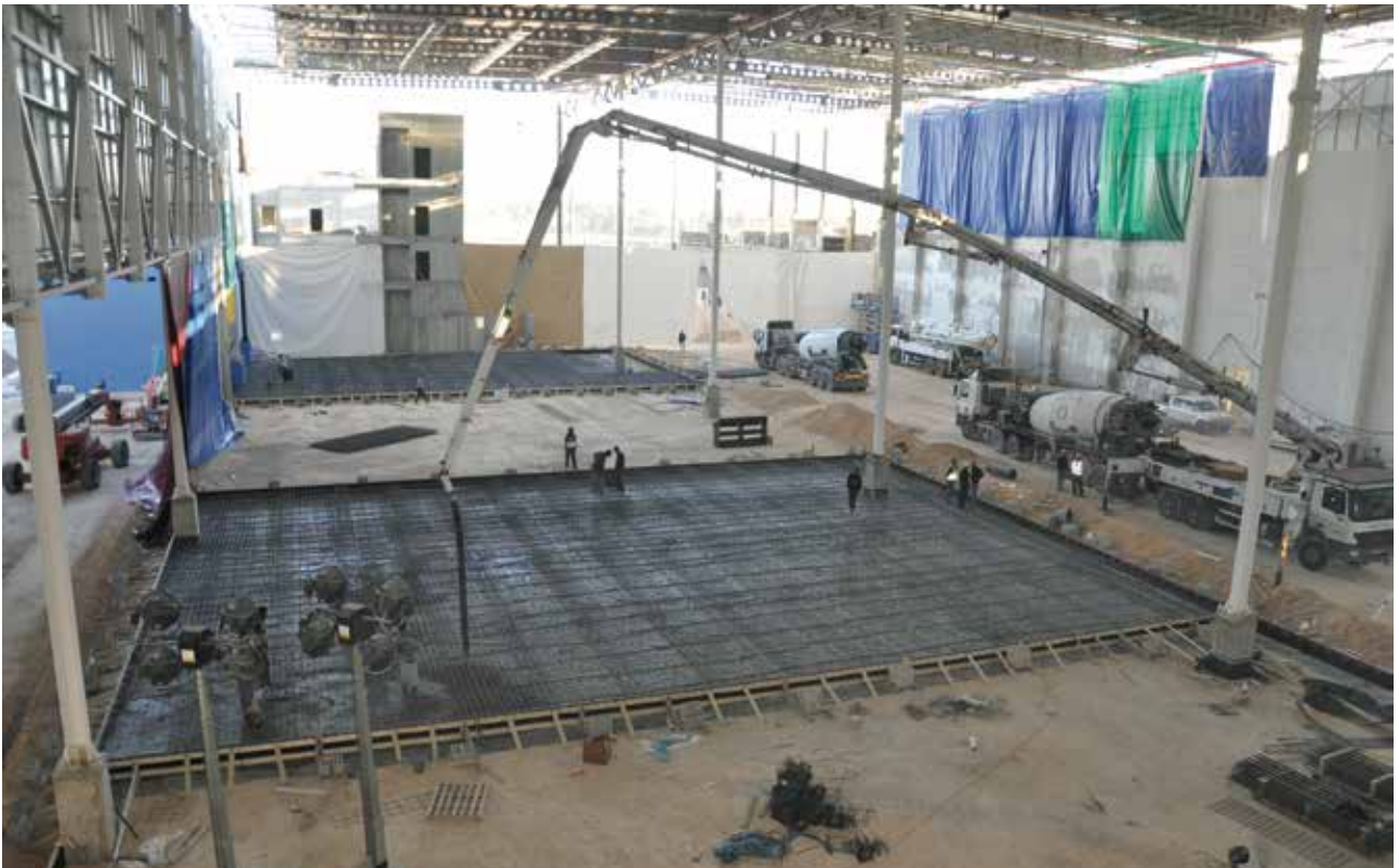
יציקת הרפסודה והספקת הבטון עם משאבה. פרויקט שבוצע במרלוג'ג שירותי בריאות כללית א.ת. הייפארק שוהם. חב' שושני את וינסטיין
