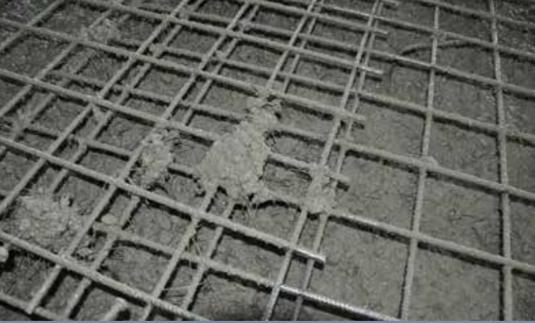
מבט מקרוב על הבטון עם סיבי הפלדה דרמיקס 5D 65/60 BG. חב' שושני את וינשטיין
